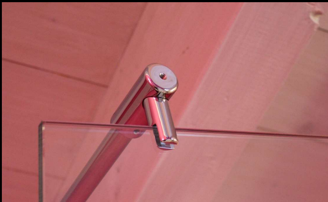
Dettaglio morsetto barra fermavetro
